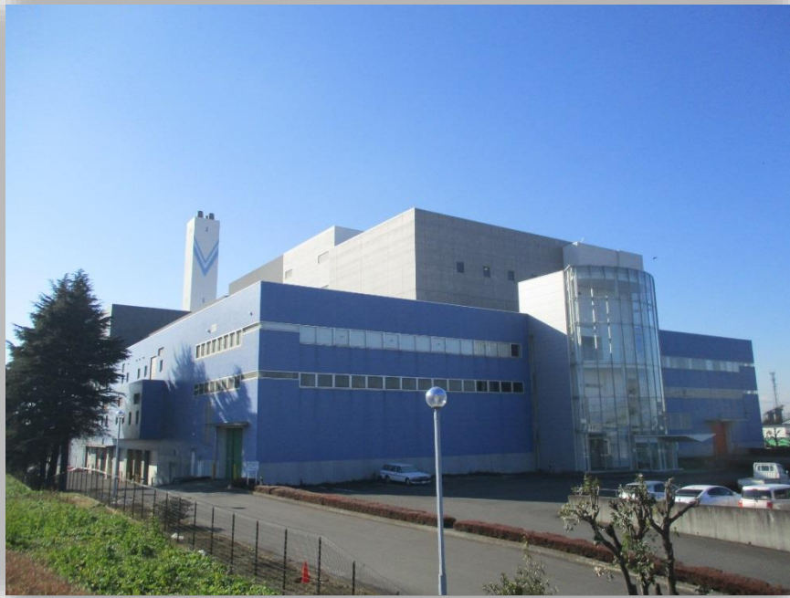
筑西広域市町村圏事務組合 環境センター
